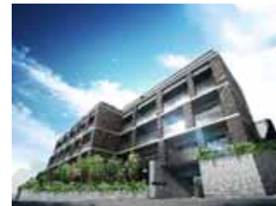
ガーデンテラス馬込プレミアム (JV) 新築分譲マンション
