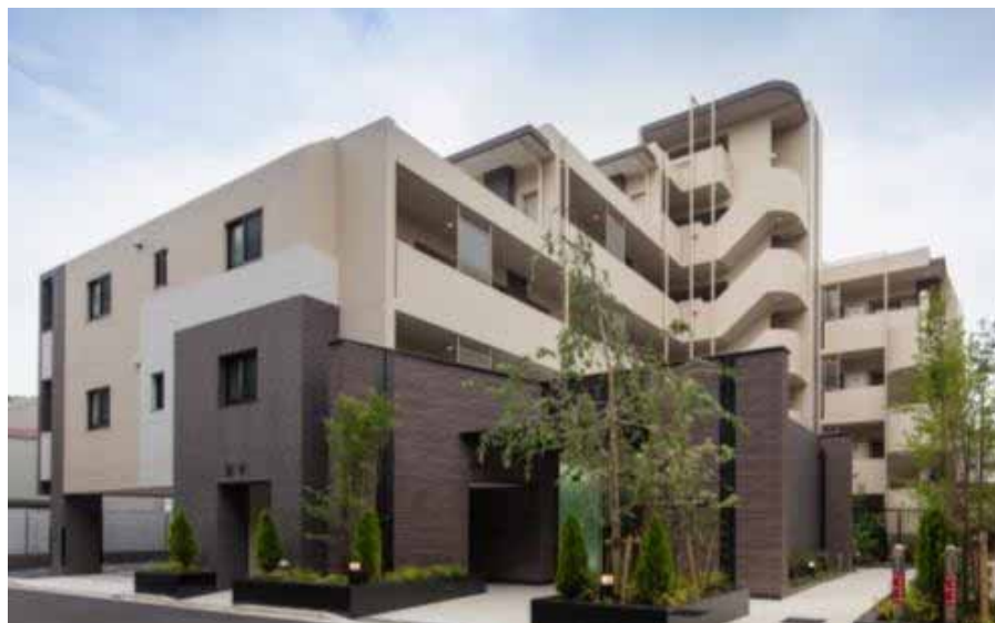
国立ガーデンテラス（2014年5月竣工）
